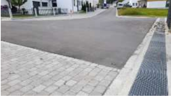
Bild: Die fertiggestellten Verkehrswege am Bergweg
