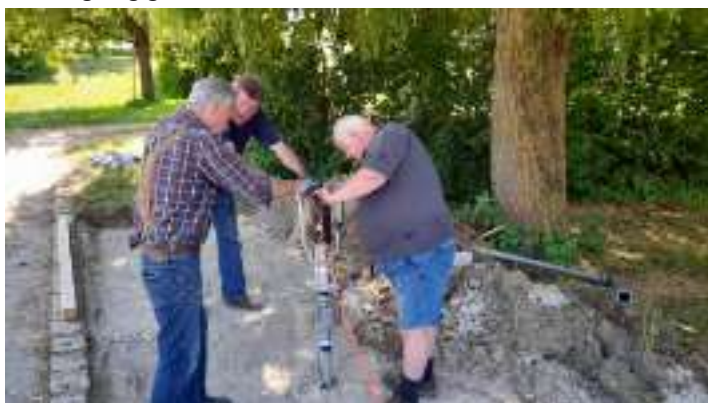
Bild: Die Montage der Schraubfundamente erforderte viele Helfer (Text und Bild: Alois Leeb)
