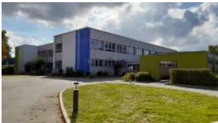
Bild: Anstrich und Reinigung geben der Schule ein neues Aussehen
